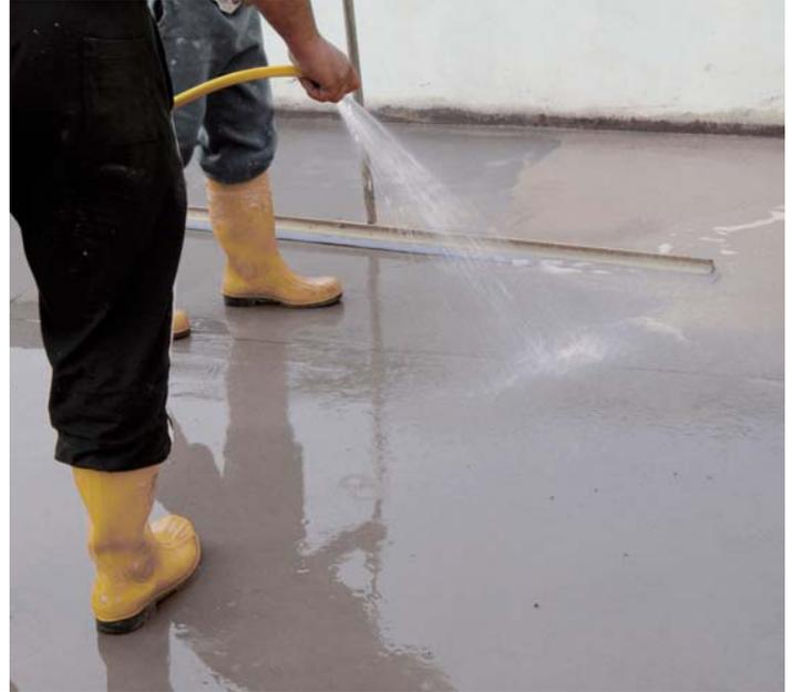
Schnitt des fertigen Industriebodens mit Endbearbeitung mit SPOLVERO AL QUARZO und folgender Wäsche.
