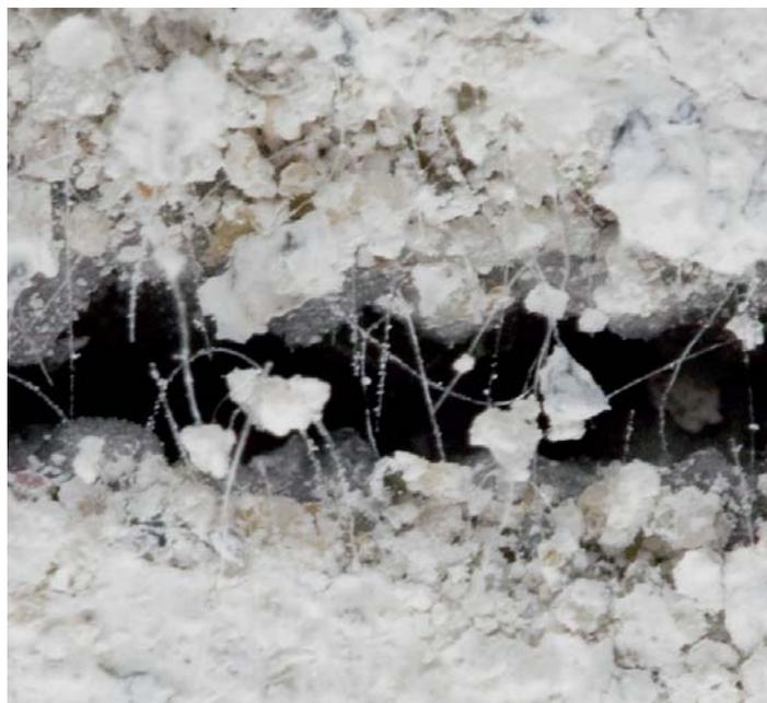
L'aggiunta di fibre all'impasto crea una microreticolatura che contrasta le cavillature superficiali. Nell'immagine l'intonaco è stato volutamente strappato per evidenziare la presenza delle fibre in polipropilene.
