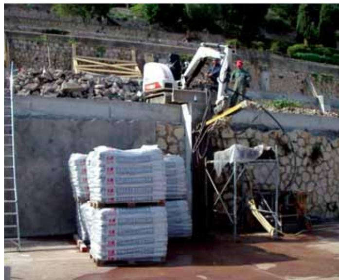
Terrazzamenti realizzati con muri di contenimento e contrafforti in CALCESTRUZZO FIBRATO strutturale.
