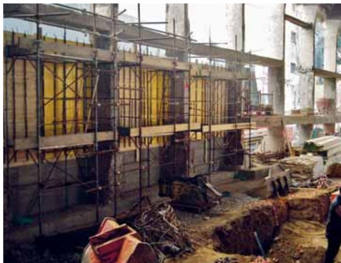
Muri di contenimento contro terra realizzati con CALCESTRUZZO FIBRATO strutturale nella ristrutturazione di uno spazio commerciale a Milano.
