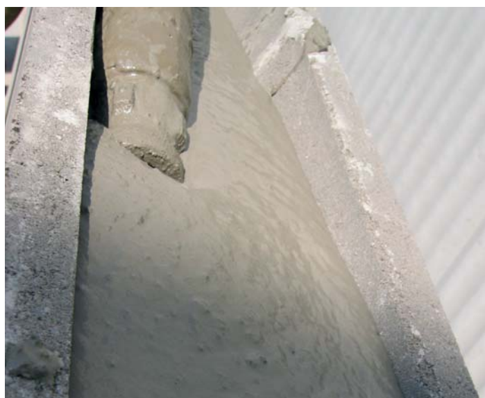
Pumpen von COMPAT GRIGIO in befestigte Formblöcke.
