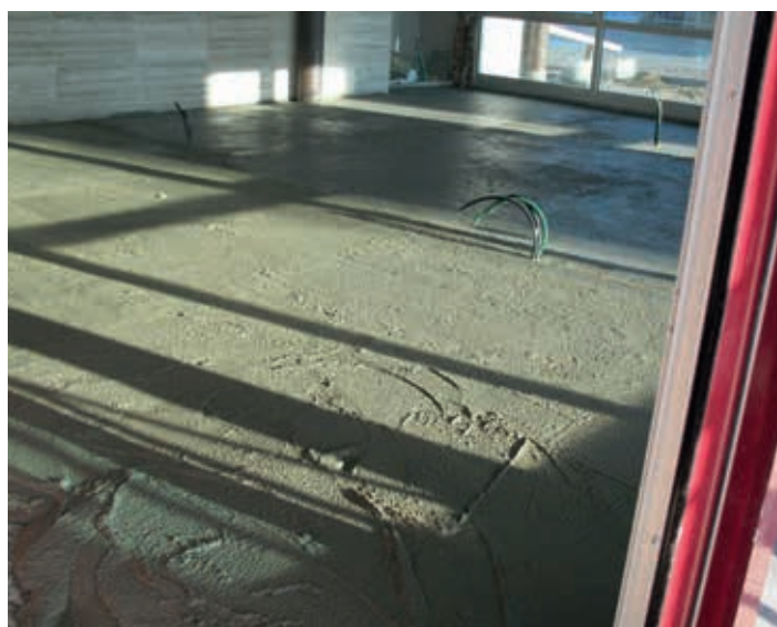
Realizzazione di sottofondo alleggerito con STRATOFOND.
