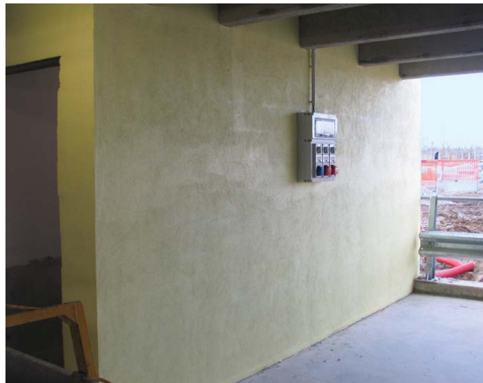
Interno di un padiglione della nuova fiera Pero-Rho, intonacato con MALTA BASTARDA FIBRORINFORZATA.
